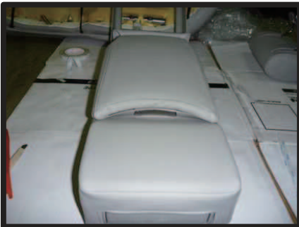
⑮カバーのラインを整えます。2 列目アームレストの完成です。 背もたれに戻します。
