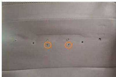
5 テーブルを固定していたボルト穴です。中央2ヶ所の○印の穴は、テーブル側に付いている突起状のパーツが刺さる穴になります。
